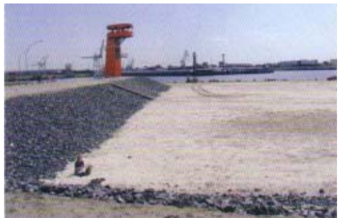
Aufgehöhte öffentliche Straße im Vorlauf zum Hochbau – Elevated public road before building construction
