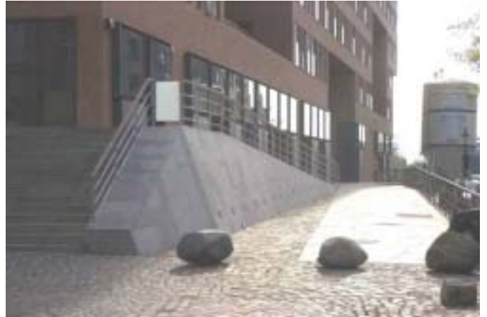
Objektschutz: Treppe und Rampe am Sockelgeschoss – Object protection: Stairs and ramp outside the basement
