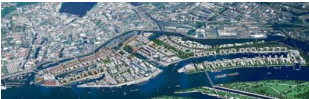
Gebiet der HafenCity im Jahr 2020 – Area of the HafenCity in the year 2020
