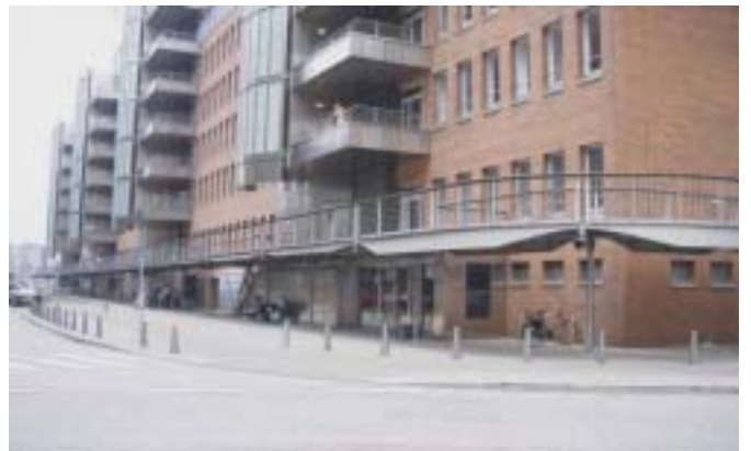
Hoch liegender Rettungsweg – Emergency service way above design water level
